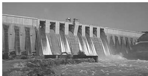
Fig. 3 – La diga di Manantali (1988), situata in Mali sul maggiore affluente del Senegal (il Bafing), trattiene le acque piovane a monte, costituendo una riserva di 12 miliardi di m<sup>3</sup> d'acqua (foto: www.omvs-soe.org)
