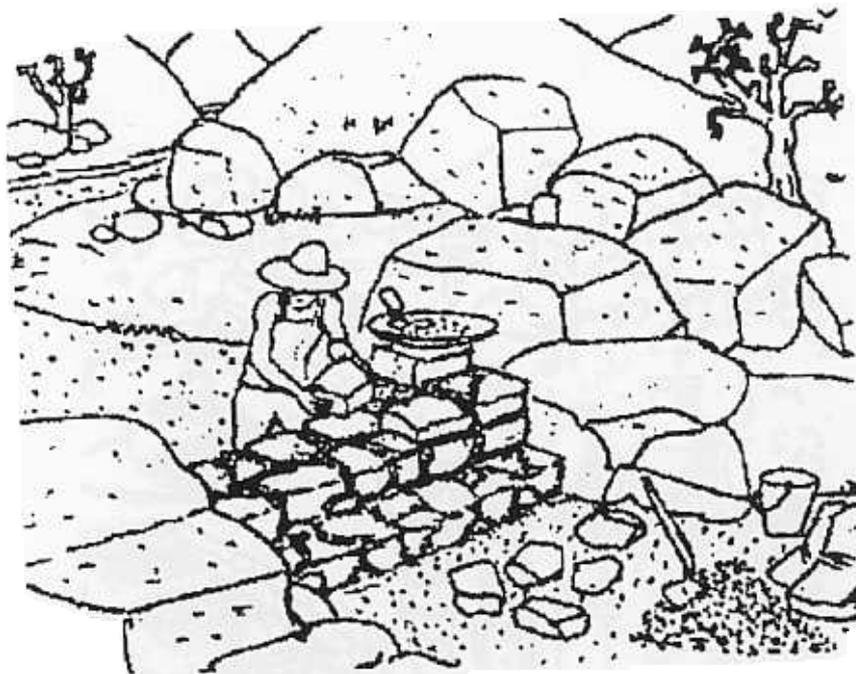
Fig. 12. Costruzione di un bief in pietra e cemento (Charniaux, 1996a).
