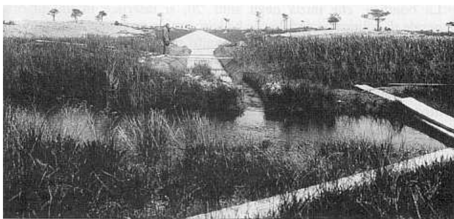
Fig. 4 – a) Il territorio bibionese intorno al 1920, prima della bonifica; b) Primi interventi di bonifica (Foto Consorzio Destra Tagliamento).
